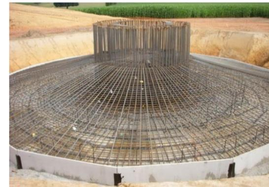
Photo 3 : Excavation et préparation de l'armature
