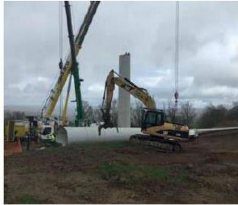
Photo 7 : Démontage d'un mât
